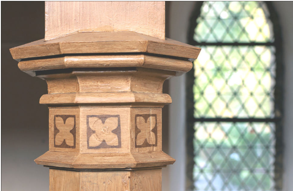
Durch Restaurator Thormeier (Stralsund) wiederhergestelltes Ornament an einer Kirchensäule
